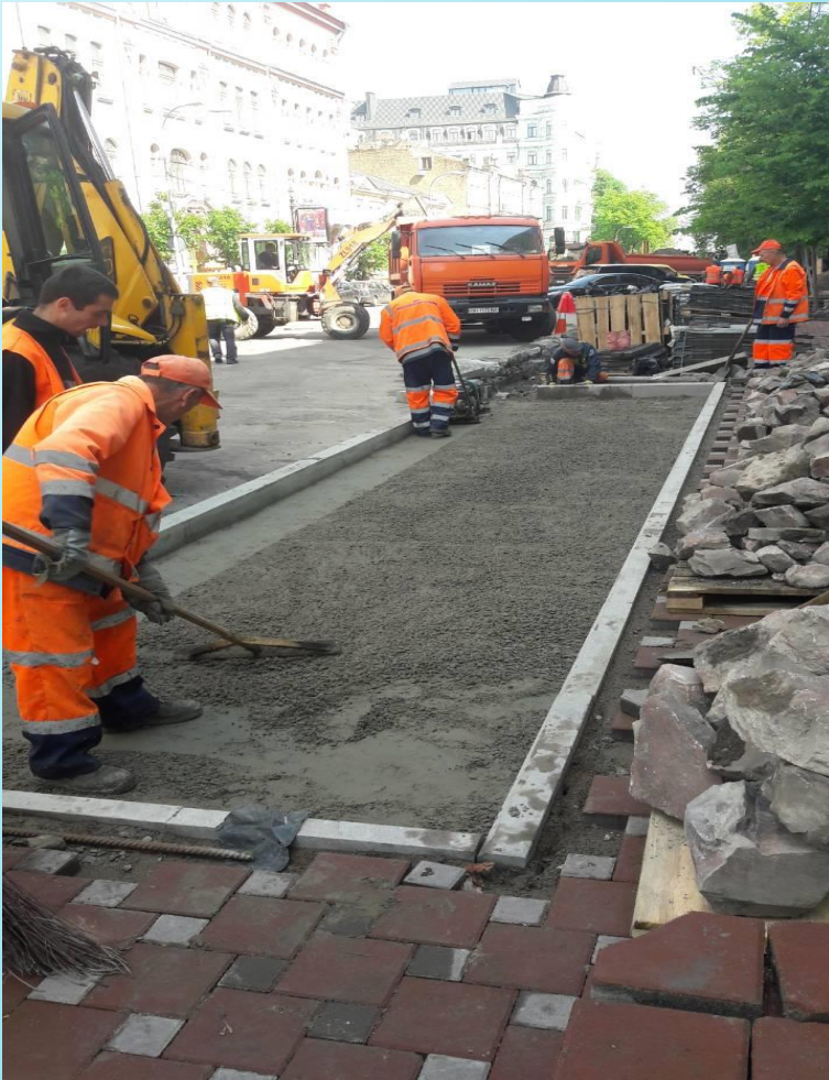
Влаштування паркувальних карманів на вул.Б.Хмельницького
