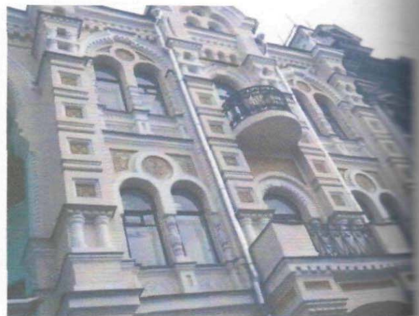
Загальний вид будівлі де розташований Об'єкт оцінки
