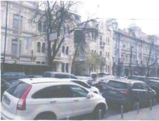
Загальний вид будівлі де розташований Об'єкт оцінки
