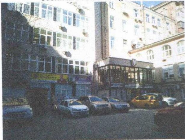
Зовнішній вигляд будівлі.
