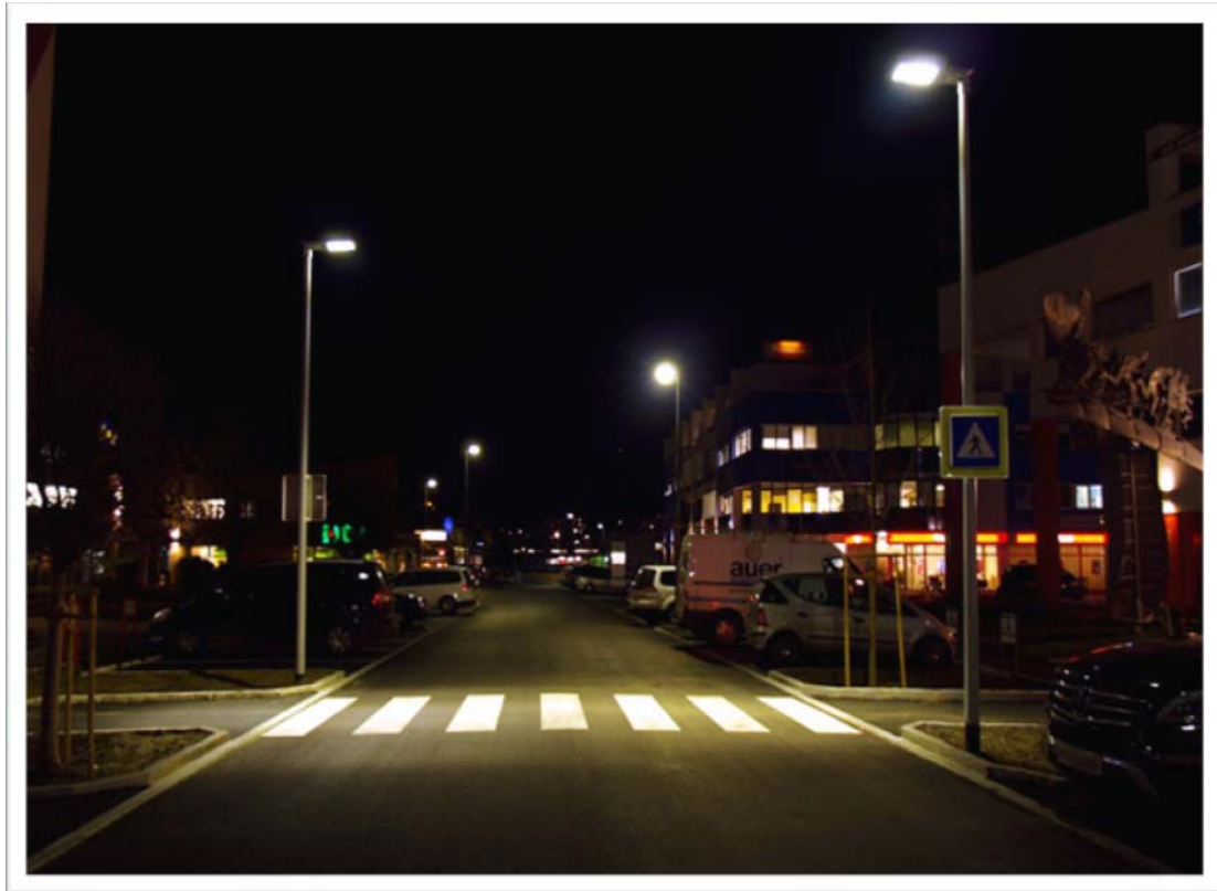
Приклад освітлення пішохідного переходу
