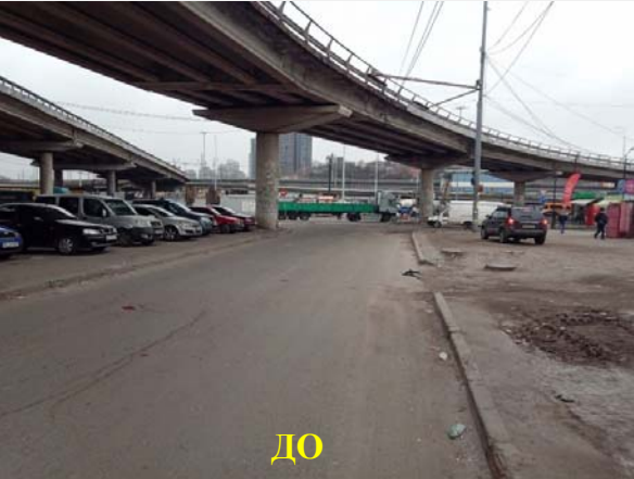
Поточний (середній) ремонт вул. Інженерна – 2020 р.
