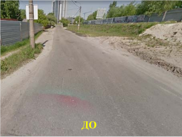
Поточний (середній) ремонт вул. Лютнева 2021 р.
