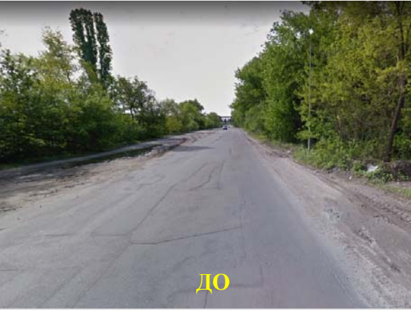
Поточний (середній) ремонт вул. Камишинська – 2022 р.
