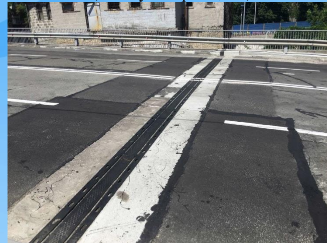
Влаштування нових деформаційних швів
